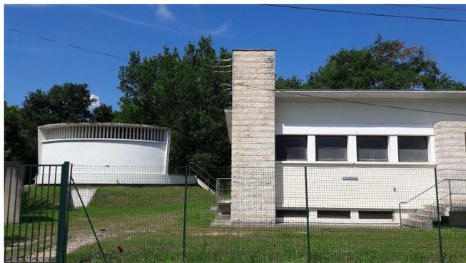
Cette station est composée d'un forage (La Pailleyre) qui est comblé, d'un local d'aération, d'une désinfection, d'une bache d'accumulation, et d'un pompage de reprise.
